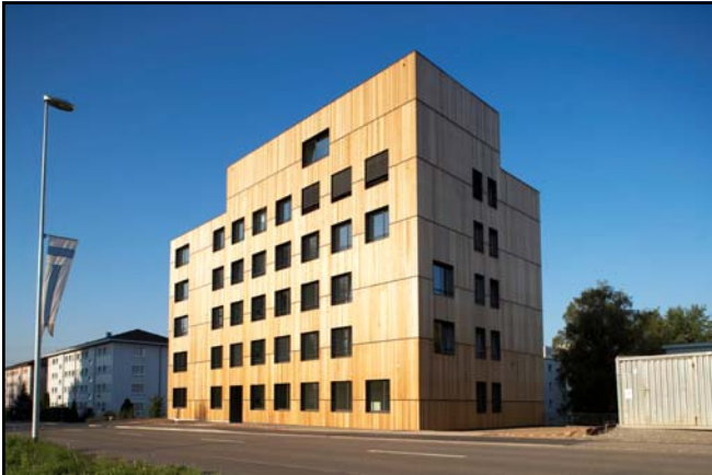
MFH Holzhausen, Steinhausen
