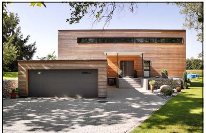
Einfamilienhaus mit individueller Architekturlösung in Wetzikon ZH
