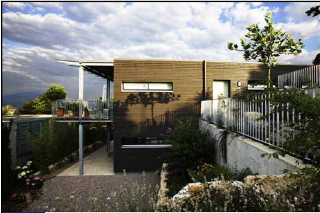
Einfamilienhaus mit individueller Architekturlösung in Dornach SO
