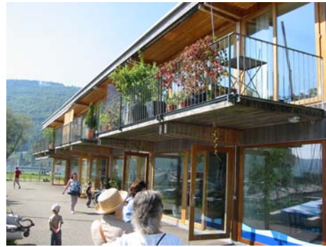
Barkenhafen Nidau, Pavillon Nord
