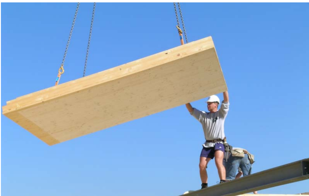
Zimmermann bei der Arbeit (Quelle: Minergie, Bern/LIGNUM)
