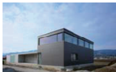
Einfamilienhaus Müller, Obergösgen
