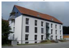
Neubau Mehrfamilienhaus, Starrkirch-Wil
