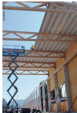
Das Dach der neuen Halle wird mit Dachrippenelementen aus BauBuche gedeckt
