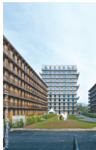
Die drei Langhäuser auf dem Zürcher Freilager-Areal sind ein Paradebeispiel für urbanen Holzbau.
