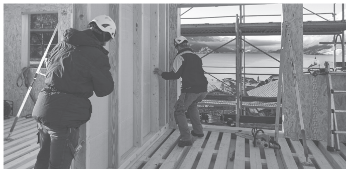
Die Holzbauelemente werden mit einem Kran an ihren Bestimmungsort gehoben, genau platziert und anschliessen fest verschraubt.
