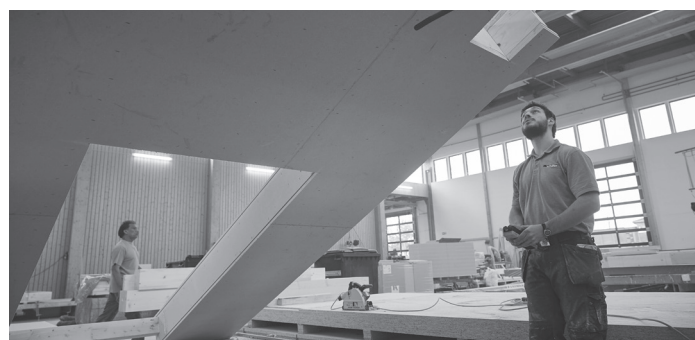
Die in der Halle vorgefertigten Elemente werden für den Transport zur Baustelle bereit gemacht.
