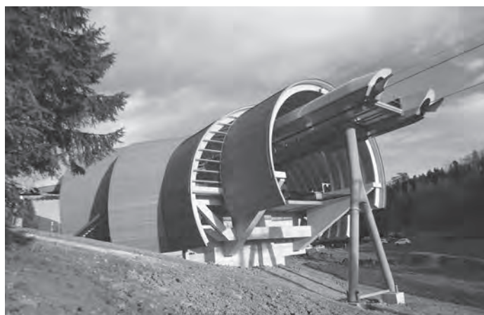
Mittelstation Seilbahn Weissenstein, Oberdorf Holzkonstruktion und Hülle sind zu 100 Prozent aus Schweizer Holz realisiert
