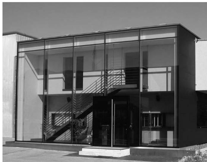
Die tragende Treppenschräge besteht aus acht fünf Meter langen eichenen Kanthölzern, die aufgrund ihrer Überlänge und besonderen Qualität aus Frankreich importiert werden mussten. Die parallel in gleichmässigen Abständen montierten Holme, die von Chromstahlelementen zusammengehalten
