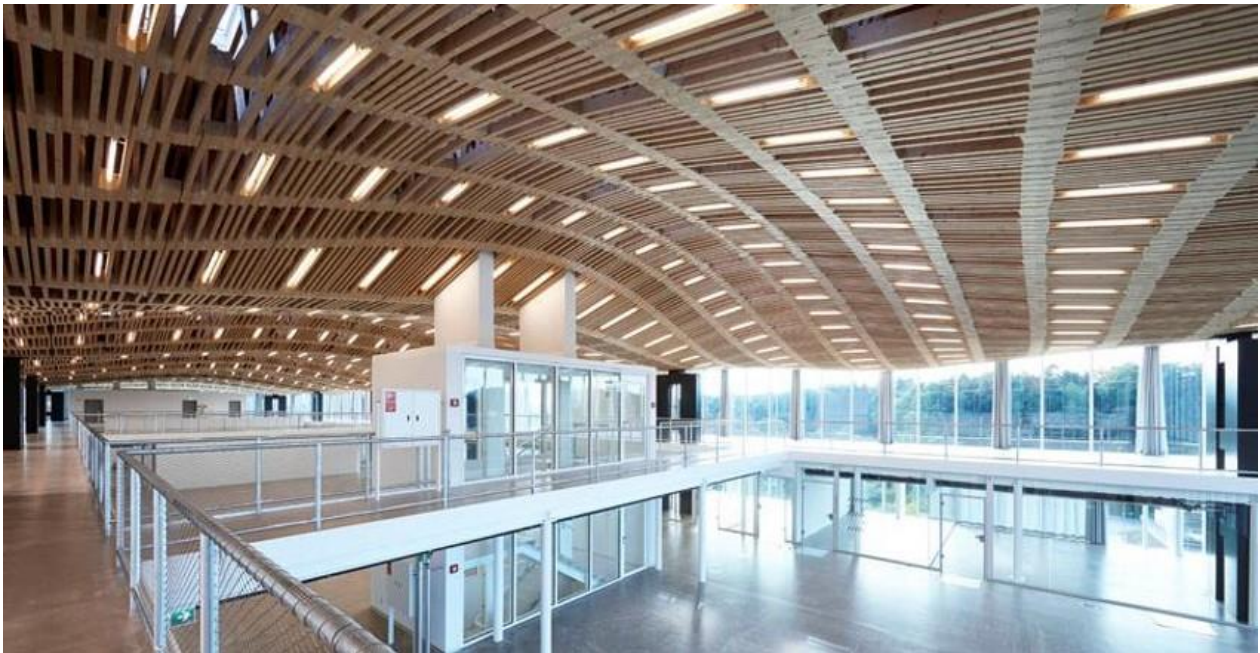
Digitaler und nachhaltiger Holzbau – Beim Dach des Arch Tec Lab der ETH Zürich haben Roboter die Pläne eigenständig in die Praxis umgesetzt. (Foto: Andrea Diglas /ITA/Arch-Tec-Lab AG)
