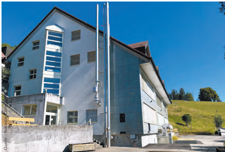
Mit klimaneutraler Holzenergie beheizt: Froburg, Wisen bei Olten
