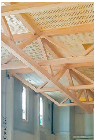
Seit 2020 wird mit Schweizer Buchenholz wieder vermehrt gebaut – so z.B. die neue Eventhalle des Campus Sursee.
