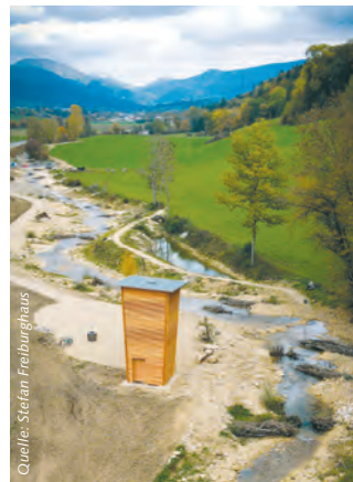
Holzturm an der revitalisierten Dünern
