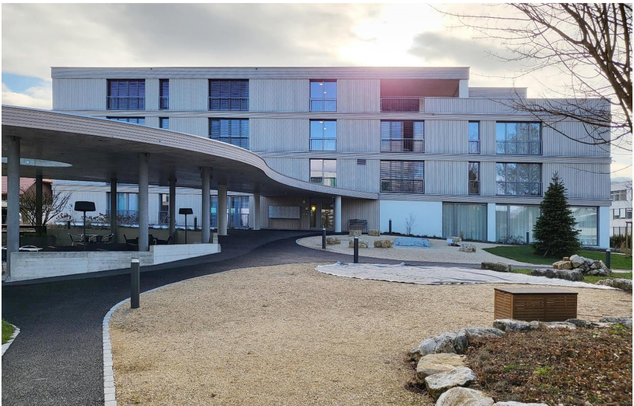
Das JeKa-Haus ist über einen überdachten Pavillon mit dem Alterszentrum Breitenbach verbunden.
