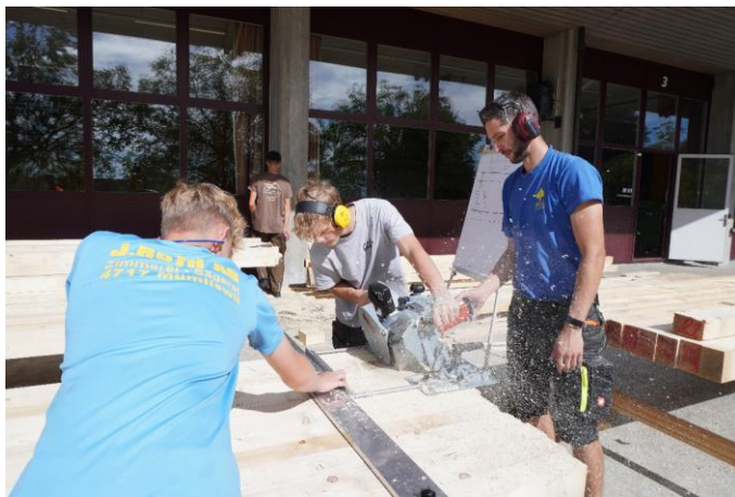
Lernende Zimmermann/Zimmerin beim Bau des Infopoints für die Solothurner Waldtage 2024
