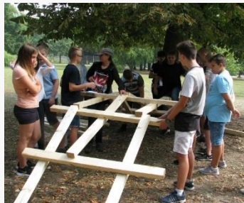
Leonardo Brücke (Späti Holzbau AG)
