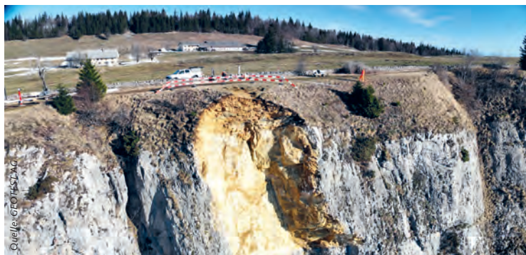
Felsabbruch Wandfluh vom 5. Januar 2026
