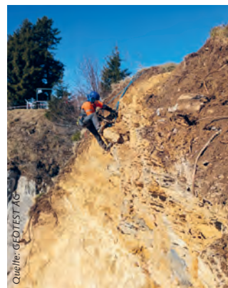
Felsreinigung am hängenden Seil.
