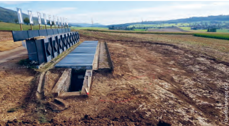
Fertig abgetragener Sanierungsperimeter
