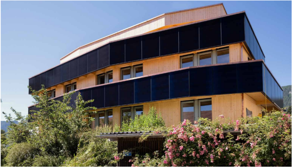
Mehrfamilienhaus und Umbau Werkstattgebäude zum Gemeinschaftshaus, Bellach
