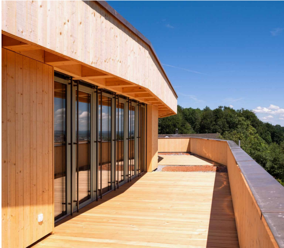
Mehrfamilienhaus und Umbau Werkstattgebäude zum Gemeinschaftshaus, Bellach
