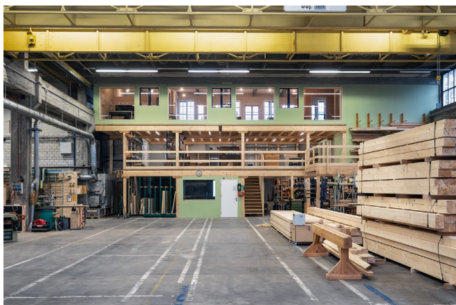
Abbildung 2: Blick in die umgebaute Sulzerhalle, wo Stahl und Beton im Bestand, durch warmes, regionales Massivholz ergänzt wird. (Fotograf: Simon von Gunten)
