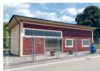
Pumpwerk Wangen b. Olten
