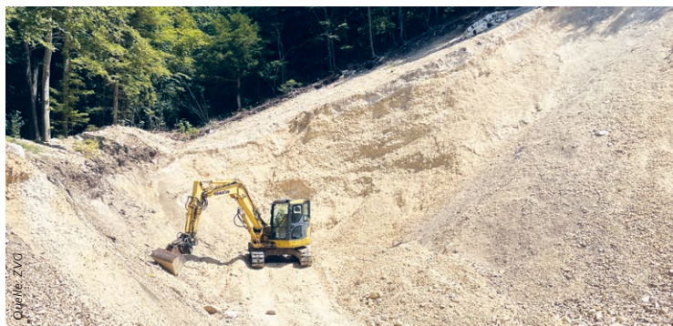
Kleinabbaustelle der Einheitsgemeinde Holderbank am Schattenberg.
